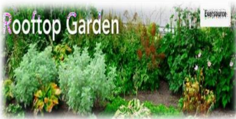
Figure 54 : Toit végétalisé Source : ctsciencecenter.org/visit/exhibits/rooftop-garden/
