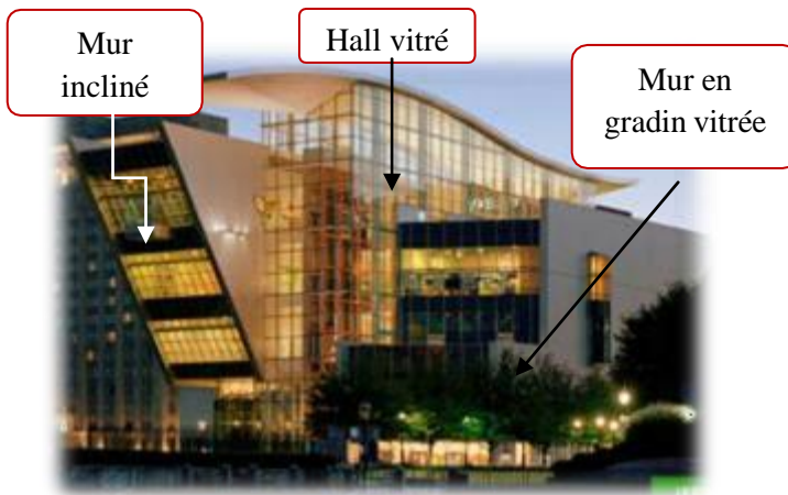
Figure 47 : vue sur la façade est la nuit Source : http://pcparch.com/project/connecticut-science-center
