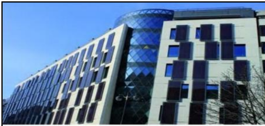
Figure 18 : La façade est dotée de volets coulissants motorisés en panneaux photovoltaïques.
