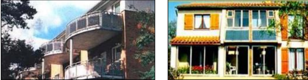
Figure 24 : Les capteurs solaires en garde-corps et en allège.
