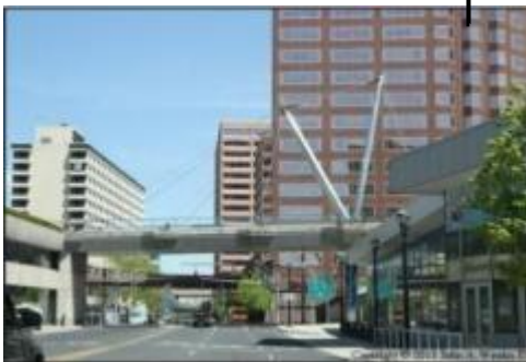
Figure 40 : Pont piétonnier reliant le projet au phoenix building Source : johnweeks.com
