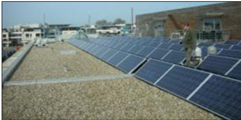
Figure 22 : Intégration des capteurs en toiture terrasse.
