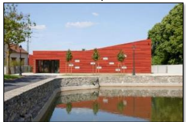
Figure 82 : la façade Nord-Est Source : ArchDaily.com
