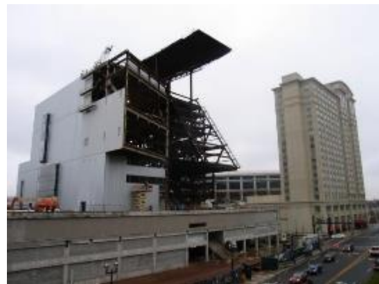
Figure 52 : la structure mixte du Science center Source : www.urbanplanet.org/forums
