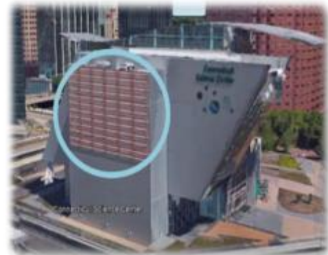
Figure 53 : système photovoltaïque sur le mur sud du projet Source : Google earth
