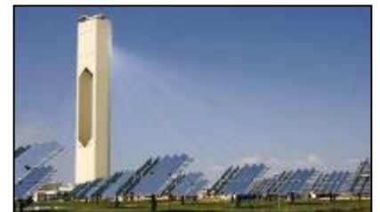
Figure 13 : Le central à tour. Source : GIZ/ Michael Netzhammer.2008
