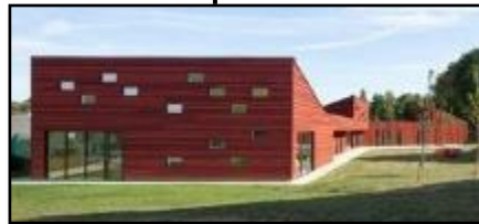
Figure 62 : vue extérieur du projet
