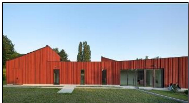
Figure 84 : la façade Sud-Est Source : ArchDaily.com
