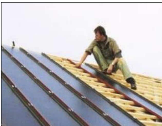
Figure 21 : Intégration des capteurs en toiture inclinée.
