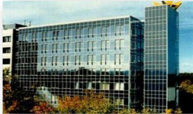
Figure 23 : Intégrations des capteurs en façade. Source : https://photovoltaïque.es.fr/
