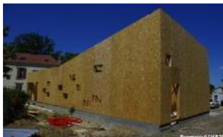
Figure 97 : Vue extérieure des panneaux OSB Source : ArchDaily.com
