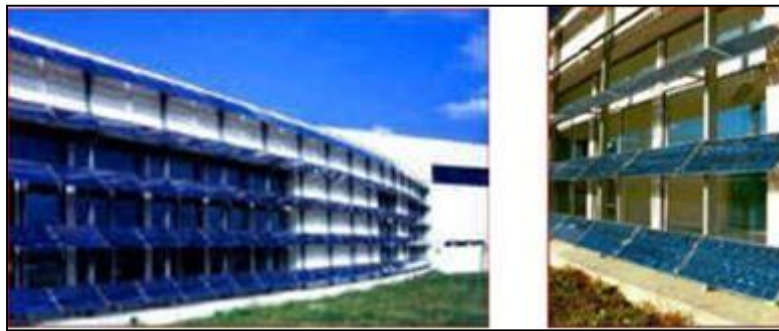
Figure 25 : Les capteurs solaires en brise soleil Source :
