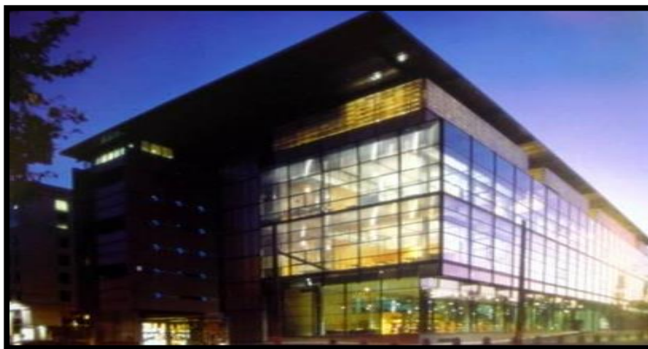
Figure 30 : photo de la médiathèque Source : Google image
