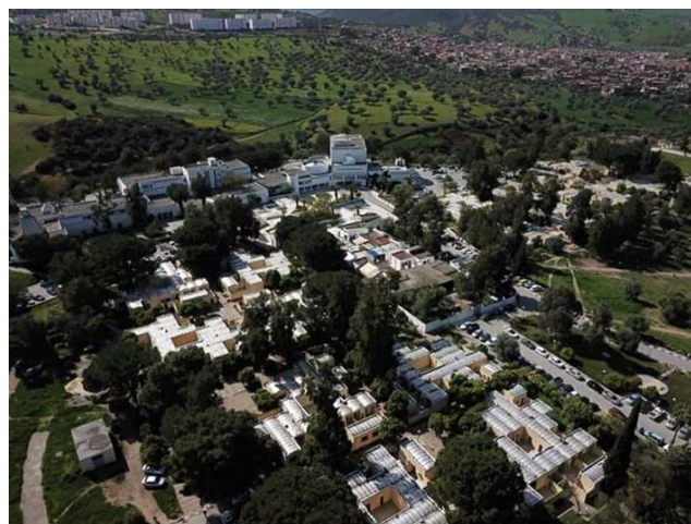
Figure 83 :vue ensemble de complexe thermal
