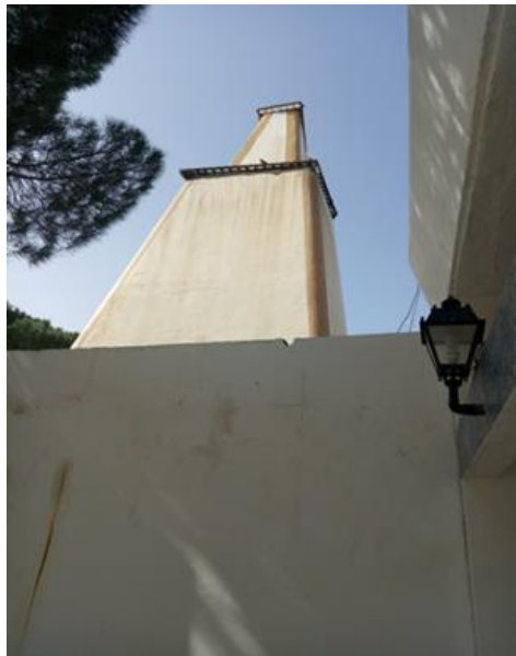
Figure 109 :le système d'aération de piscine collectif
