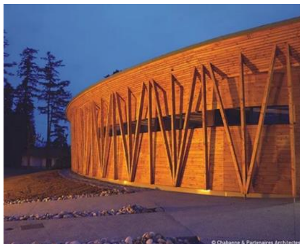
FIGURE 73 : UTILISATION DU BOIS EN FAÇADE DE PROJET
