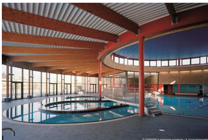
Figure 74 : utilisation de verre au niveau de piscine intérieure
