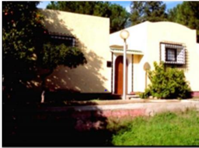
Figure 106 : façade principale de bungalow
