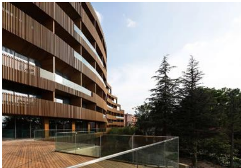
FIGURE 61 :LA FAÇADE EN BOIS
