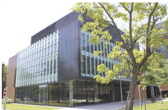
Figure 5 :bâtiment capteurs solaire Université Concordia
