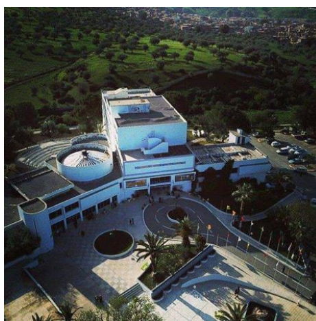
Figure 85 : vue ensemble de bloc thermal
