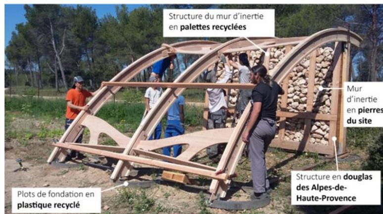
FIGURE 58 LES MATÉRIUX UTILISÉS DANS LA SERRE BIOCLIMATIQUE
