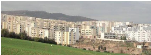
Figure 7 : Vue du Pos Sud en réalisation. (Auteur, 2020)
