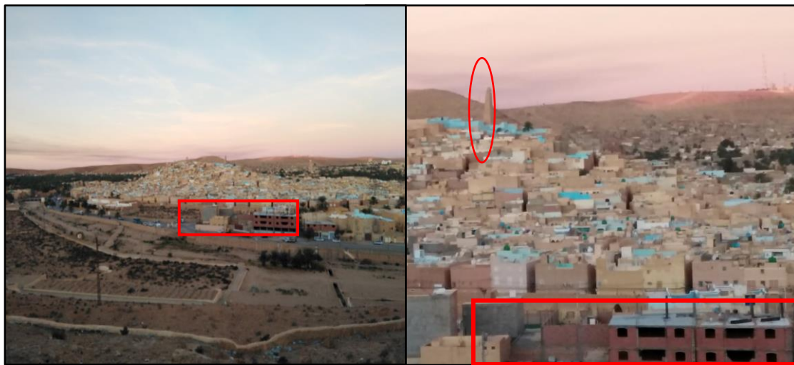
Fig. 1 : Auto construction sur le front du Ksar beni yezghen Source : Cliche personnel 2019
