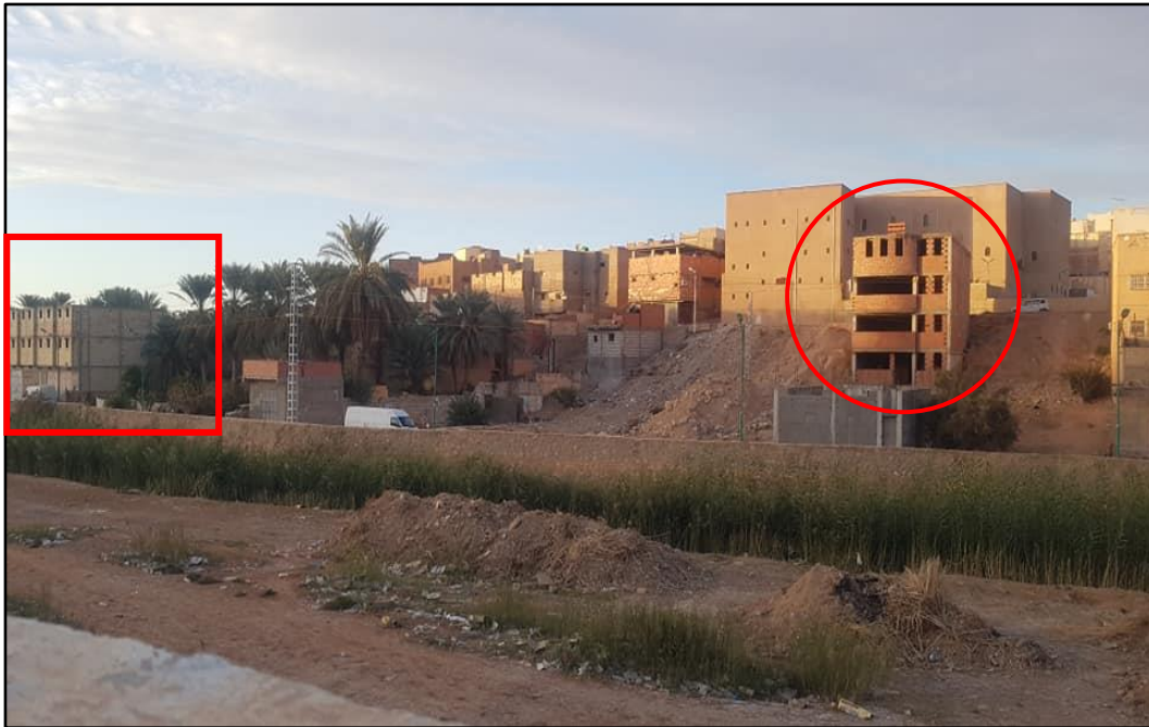
Fig. 2 : Auto construction sur le front du Melika Source : Cliche personnel 2019
