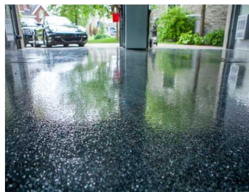
Figure VI.6. Plancher en béton polymère.
