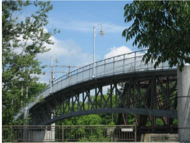
Figure V.1. Passerelle piétonnière de Sherbrooke réalisée en 1997.
