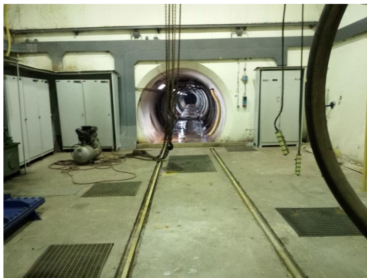
Photo III-2 : La galerie interne du Barrage Bouhamdane (juin 2019).
