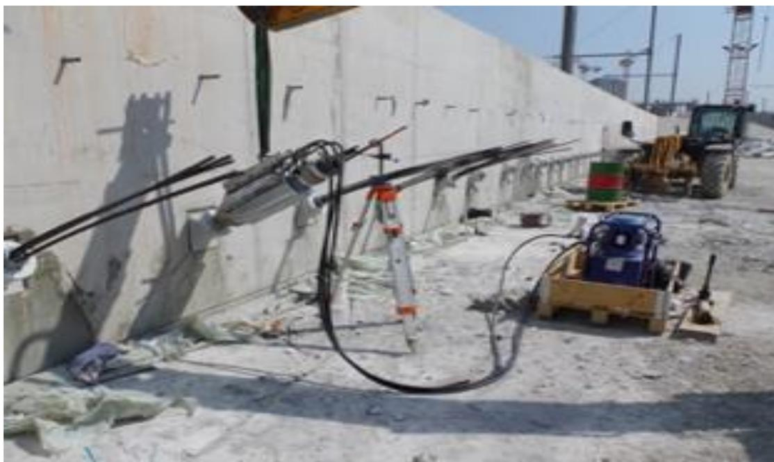
*Figure 1.6 Essai de contrôle sur un tirant d'ancrage en cours de réalisation d'après (les règles professionnelles (TA 2020), 2020)*
