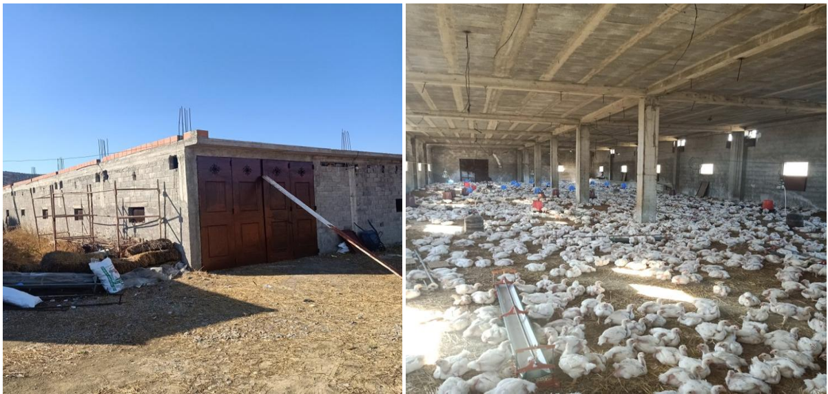
Annexe 2 : Bâtiment d'élevage N° 2
