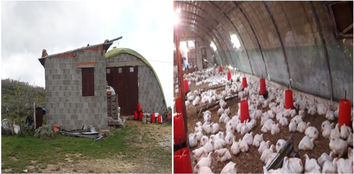
Annexe 1 : Bâtiment d'élevage N° 1
