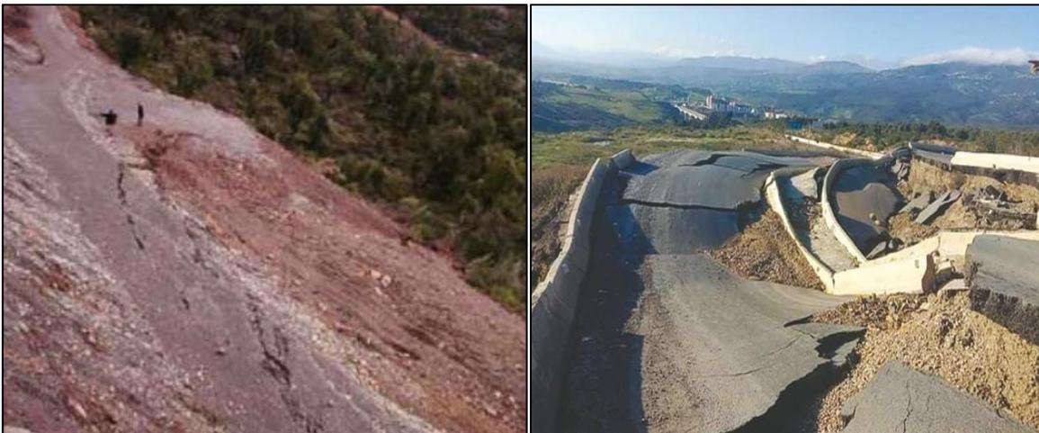
FIG. 24 Glissement de talus en sein d'un remblai routiers Bouira 2002 (gauche) et Azazga 2019 (droite)
