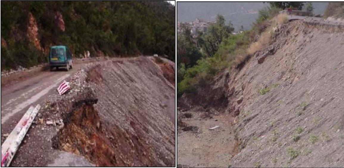
FIG. 23 Désordres dans les remblais routiers causés par les glissements des talus
