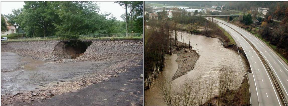
FIG. 22 Phénomène d'érosion dans les remblais routiers
