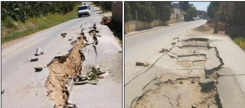
FIG. 25 Désordres dans les remblais routiers causés par les tassements
