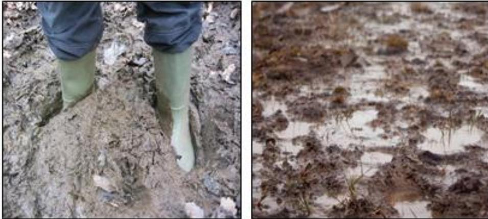
FIG. 20 Difficulté de la mise en œuvre des sols fins lors des terrassements routiers
