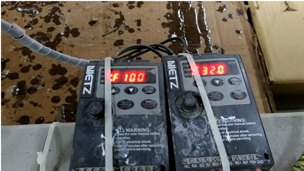
Figure 2.4 : Variateurs de fréquence électrique de la machine d'enroulement filamentaire.
