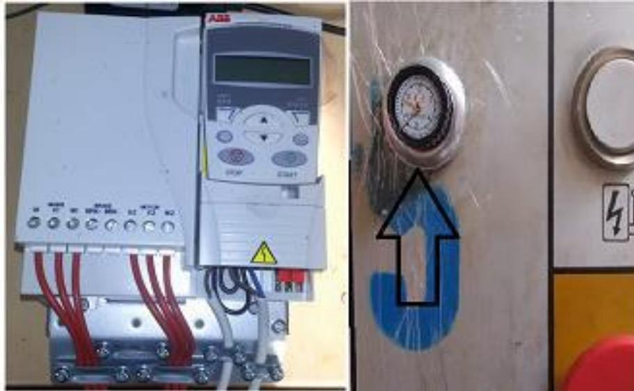
**Figure II.2:** Variateur de fréquence ABB ACS355.
