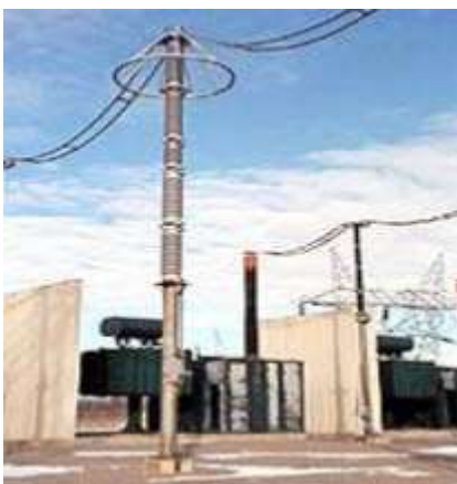
Figure I.6: Photo réelle d'un parafoudre HT [4].
