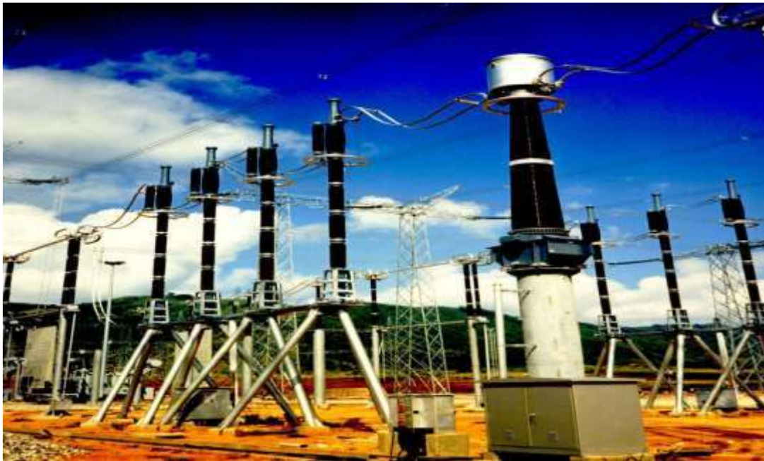
Figure I.4: Disjoncteur 800 KV [1].
