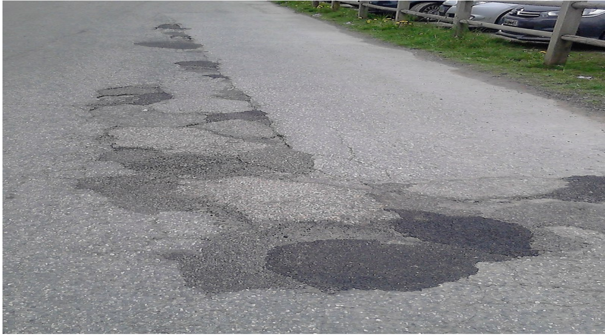
Figure I-13 :Nids-de-poule rebouchés à l'aide d'enrobé à froid. [8]
