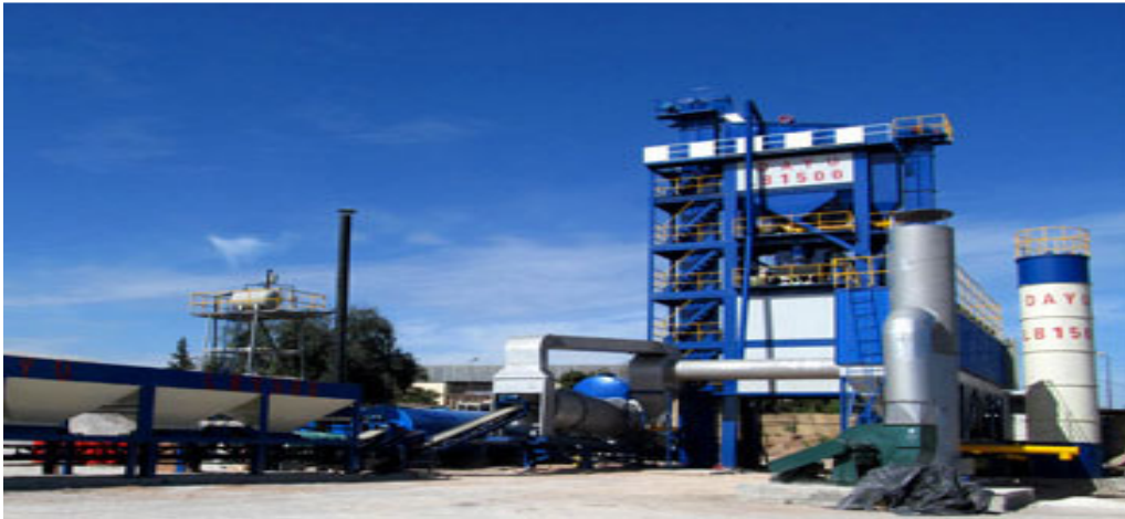
Figure I-22 : Une usine de fabrication d'asphalte. [6]
