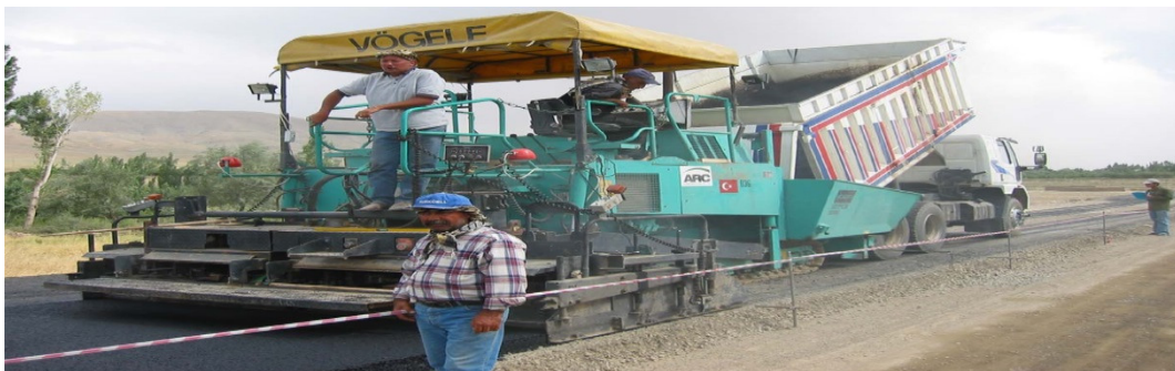
Figure I-26: Un finisseur en cours d'application, on remarque le camion vidant sa benne d'enrobé dans la trémie. [6]
