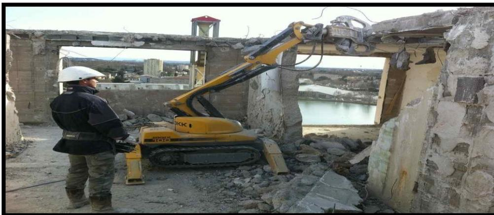
**Figure III- 9 :** La démolition par écrêtage.
