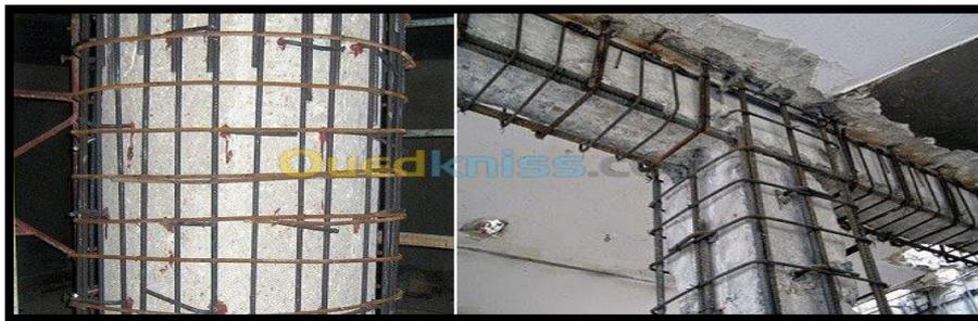
**Figure II- 6 :** Exemple d'un chemisage.
