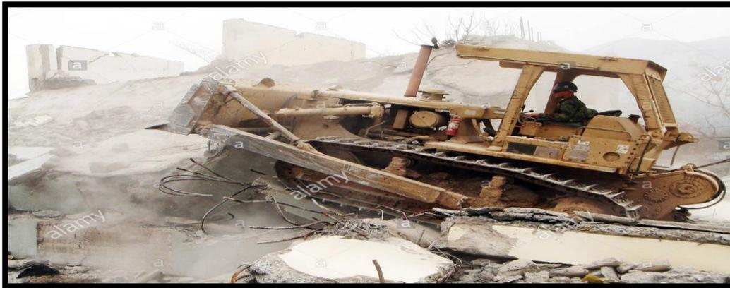
**Figure III- 8 :** La démolition par le boteur (bulldozer).
