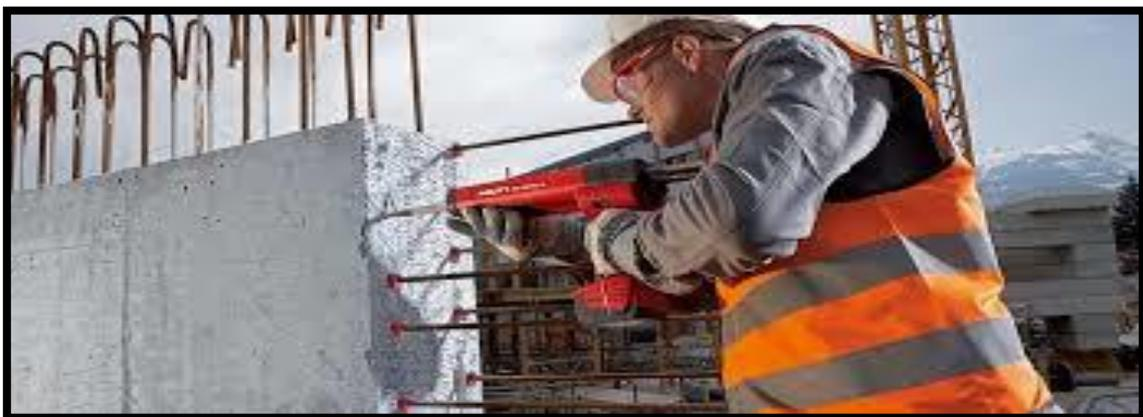
**Figure II- 11 :** Scellement chimique pour béton armé.
