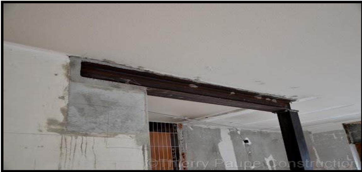
**Figure II- 10 :** Renforcement au moyen des profilés métalliques.
