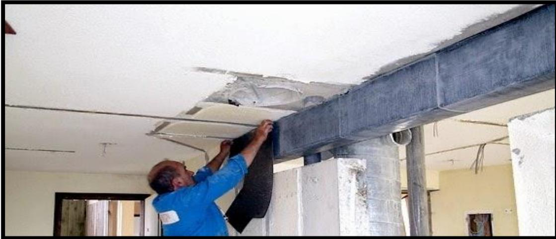
**Figure II- 3 :** La technique du tissu de fibre de carbone.
