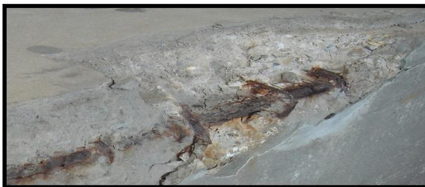
**Figure I-6 :** La carbonatation du béton.
