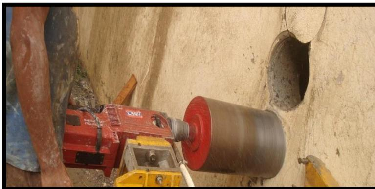
Figure IV- 4 : Carottage du béton.
