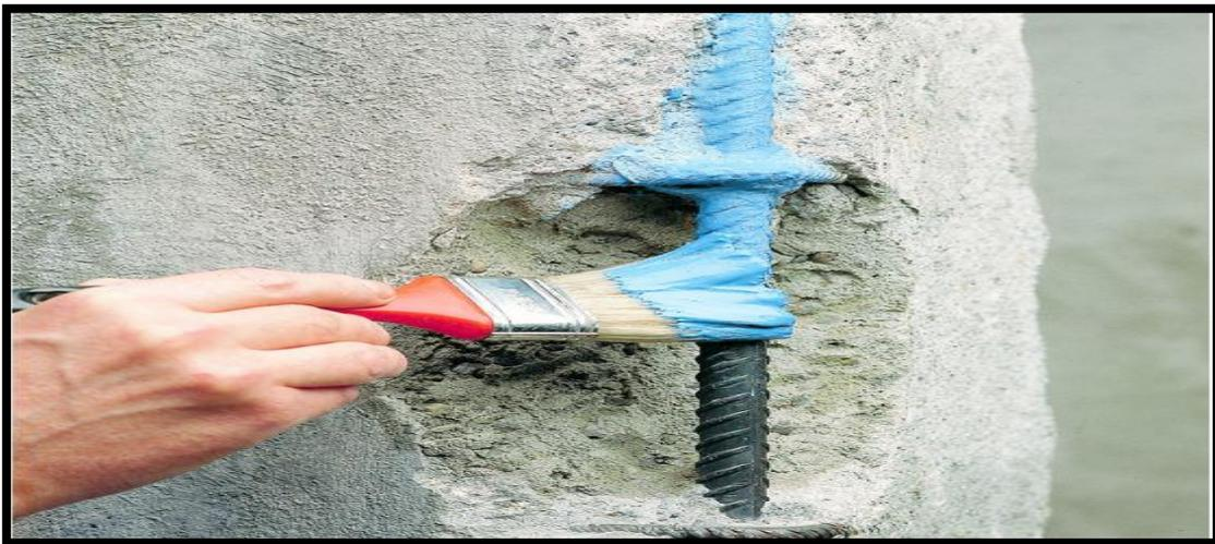
**Figure II- 4 :** La protection des armatures.
