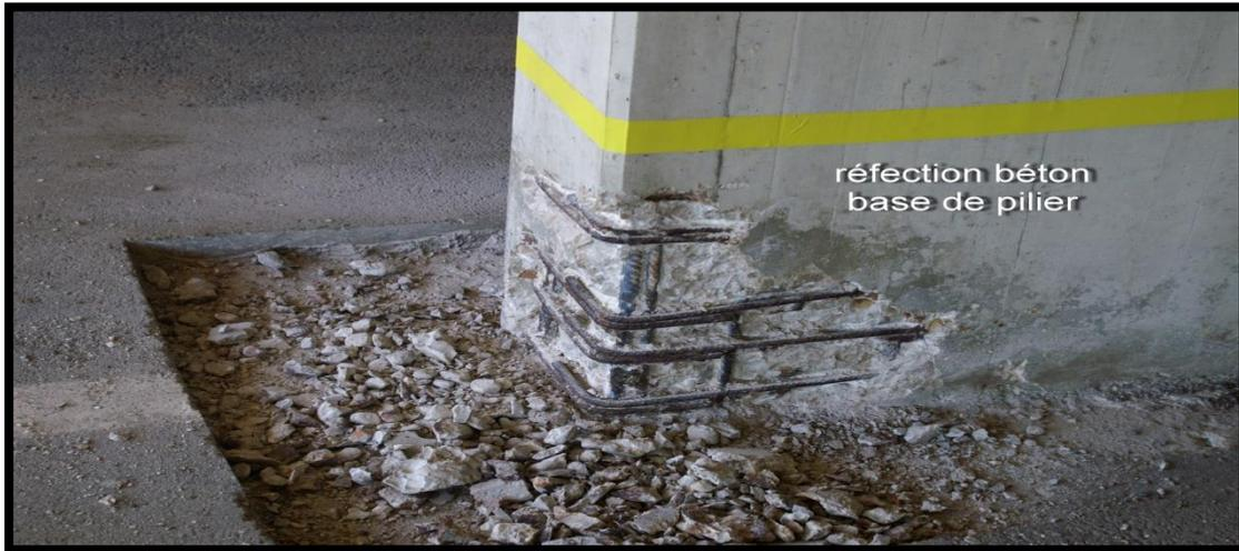
**Figure II- 5 :** La réfection des bétons.
