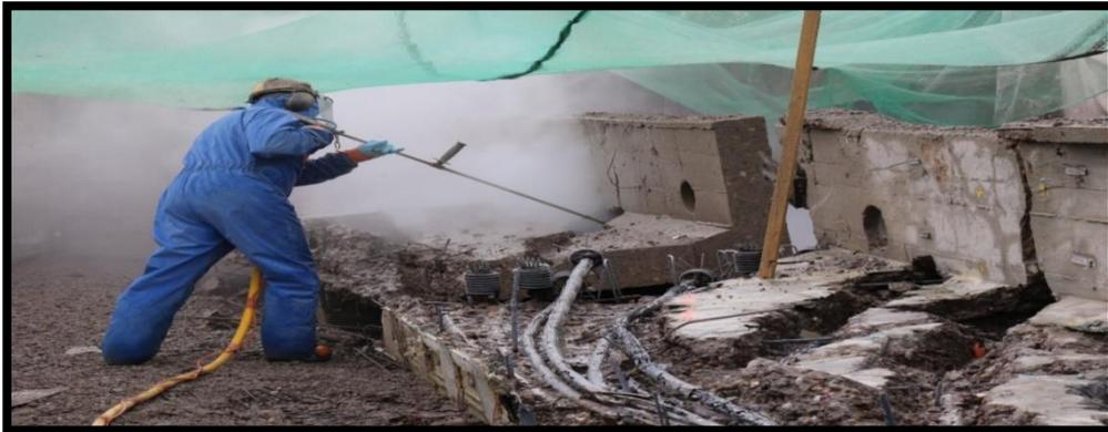
**Figure III- 15 :** Découpage par hydro-démolition.
