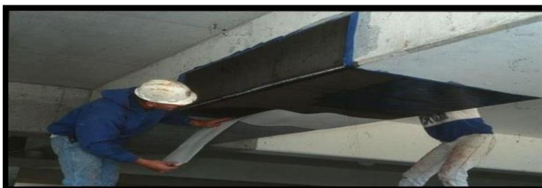
**Figure II- 14 :** Renforcement d'une poutre avec une feuille de PRFC.
