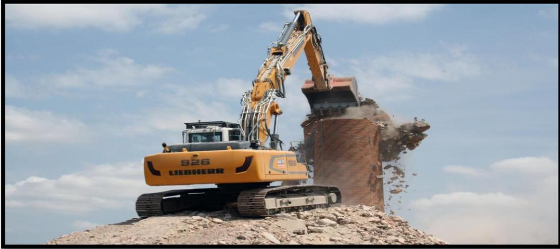
Figure III- 6 : La démolition par la pelle à godet.
