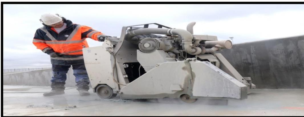
**Figure III- 16 :** Découpage par la scie au sol.
