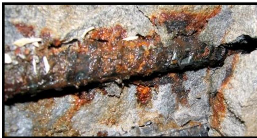
**Figure I-7 :** La corrosion des armatures.
