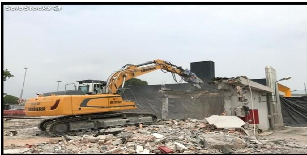
Figure III- 7 : La démolition par la pelle à croc de béton.
