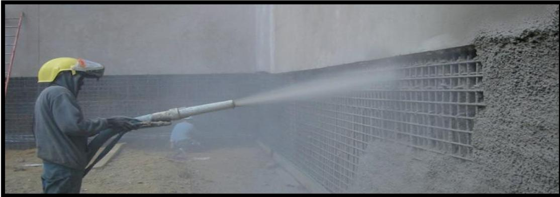
**Figure II- 1 :** La technique du béton projeté.
