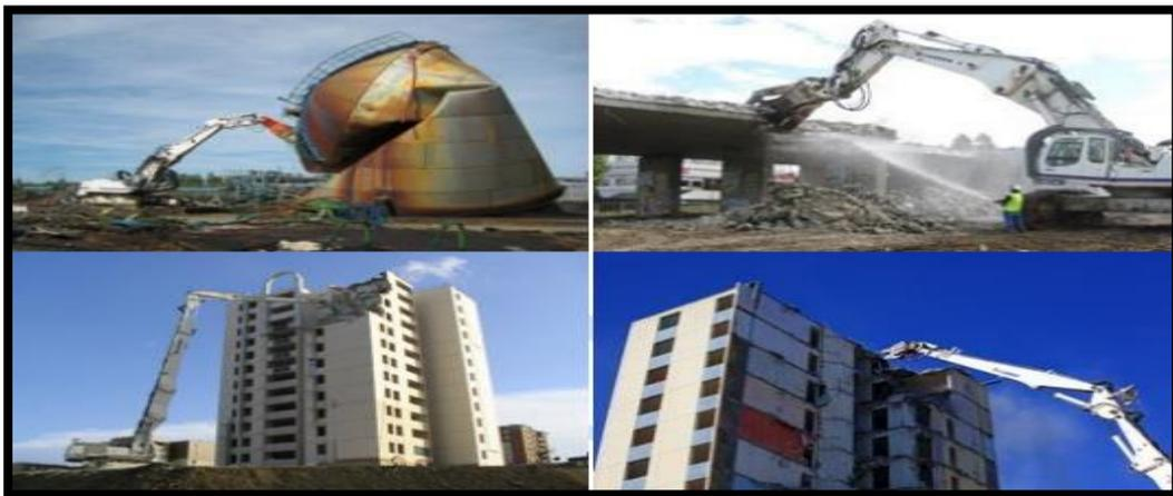
**Figure III- 4 : La démolition mécanique.**
