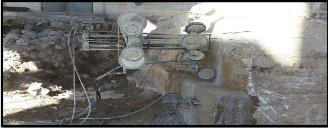
Figure III- 17 : Découpage par le câble diamanté.
