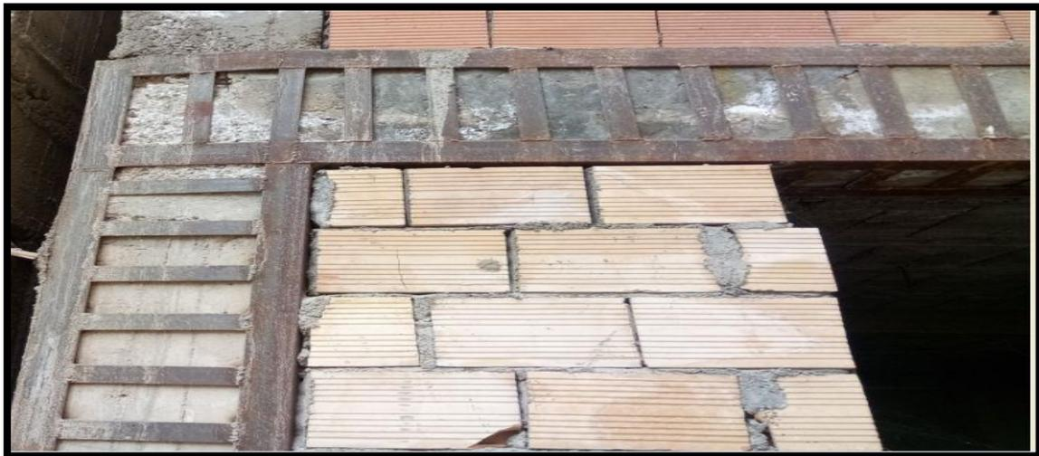
**Figure II- 8 :** Renforcement d'un portique (poteau-poutre) par la technique du gainage métallique.
