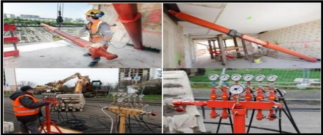
Figure III- 10 : La démolition par expansion (procédé DARDA).
