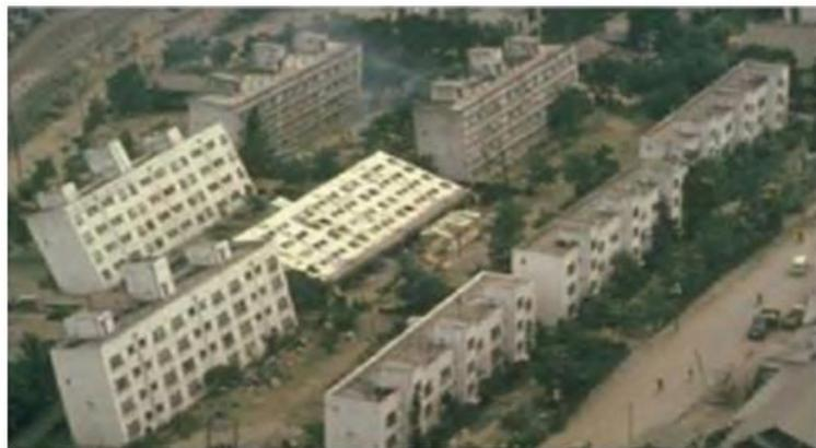
**Figure 1.12 :** Immeubles partiellement enfouis et ayant bascule à la faveur d'une Liquéfaction du sol lors du séisme de 1964 à Niigata, au Japon.
