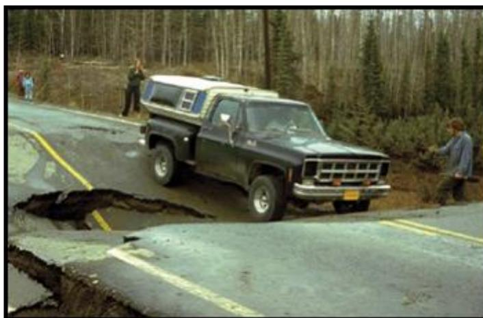
Figure 1.1 : Tassement du sol compressible sous l'effet des charges apportées par le remblai
