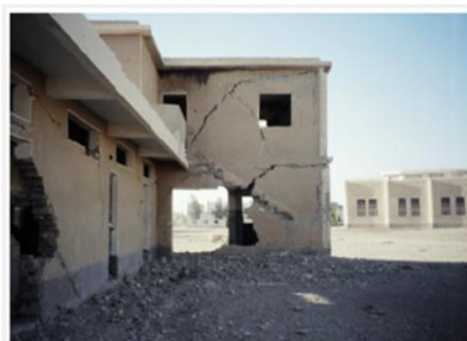
**Figure1. 11** : Bâtiments endommagés par les mouvements des sols argileux expansifs.
