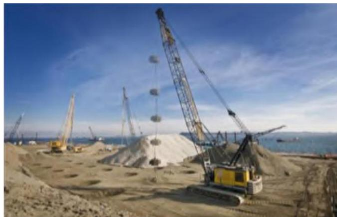
**Figure 3.1 :** Chantier d'un compactage dynamique profond.
