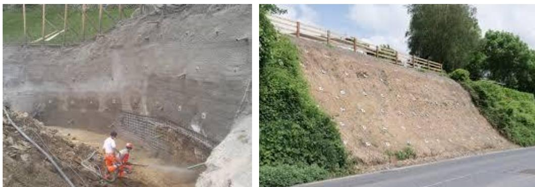
*Figure 71 : Soutènement réalisé par clouage (excavation, remblai)*
