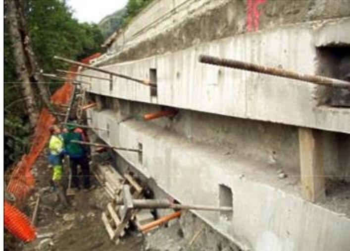
*Figure 65 : Renforcement par ancrage*
