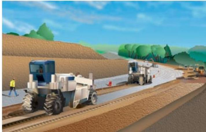
*Figure 31 : Traitement des sols aux liants hydrauliques*
