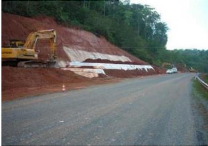
*Figure 59 : Renforcement par géosynthétiques*
