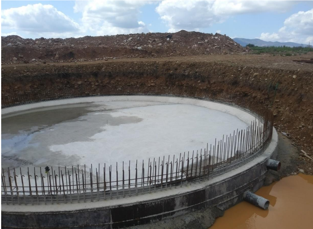
Figure IX.5: Schéma de radier.
