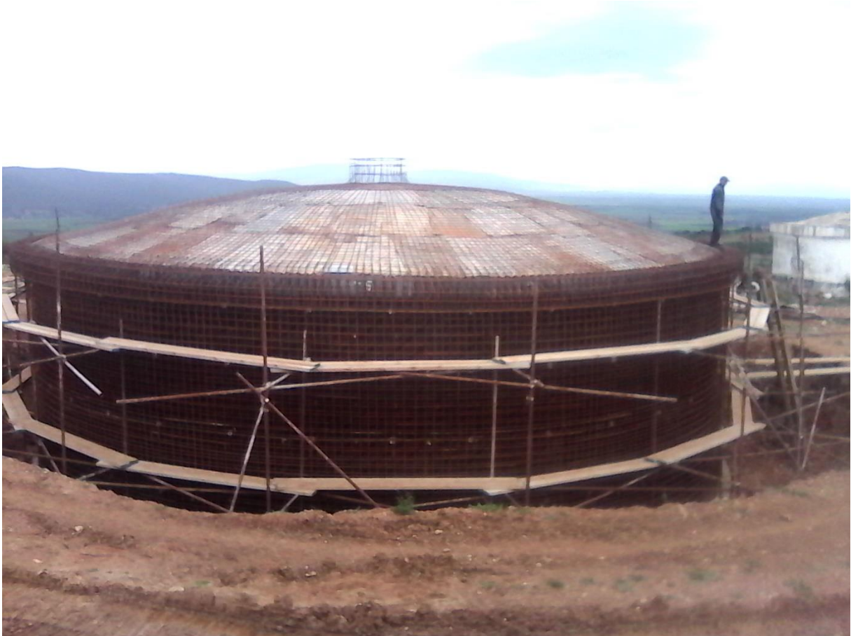
Figure X.5 : Exécution le ferrailage vertical et horizontal du fût cylindrique et la coupole y compris la ceinture supérieur (poutre dimension 40 \times 65 \text{cm}^2 ) ainsi le lanterneau.
