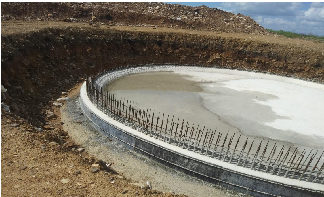
Figure X.2 : Talus de 2.20m de hauteur au pourtour de la fondation circulaire.
