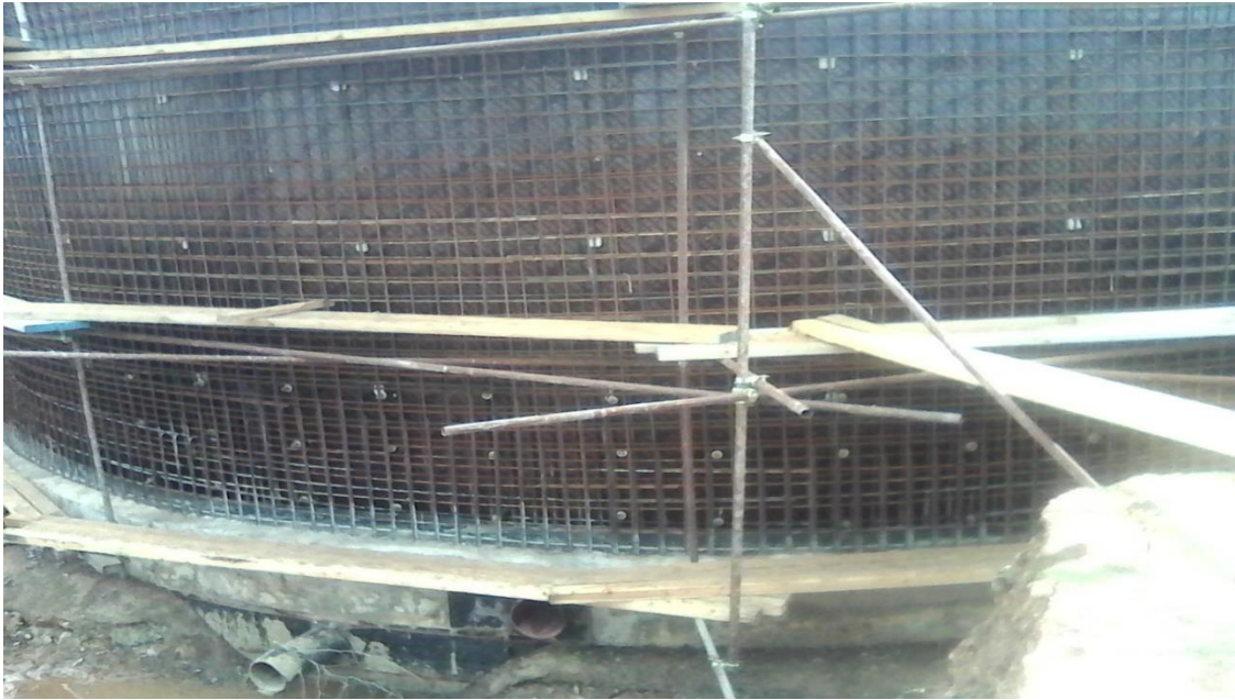
Figure X.3 : Exécution le ferrailage vertical et horizontal du fût cylindrique
