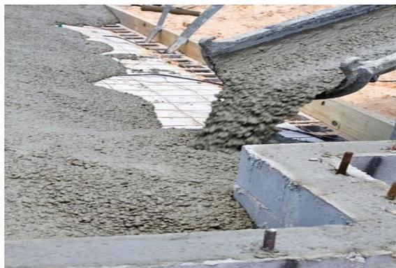
*Figure I.1. Mise en place d'un béton auto-plaçant (BAP).*
