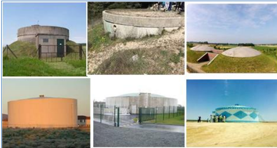
Figure II-8 : Autres exemples de réservoirs enterrés et semi-enterrés
