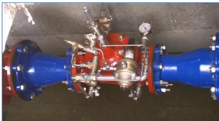
Figure V-5 : Stabilisateur de pression
