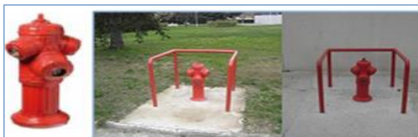
Figure II-22 : Poteaux d'incendies
