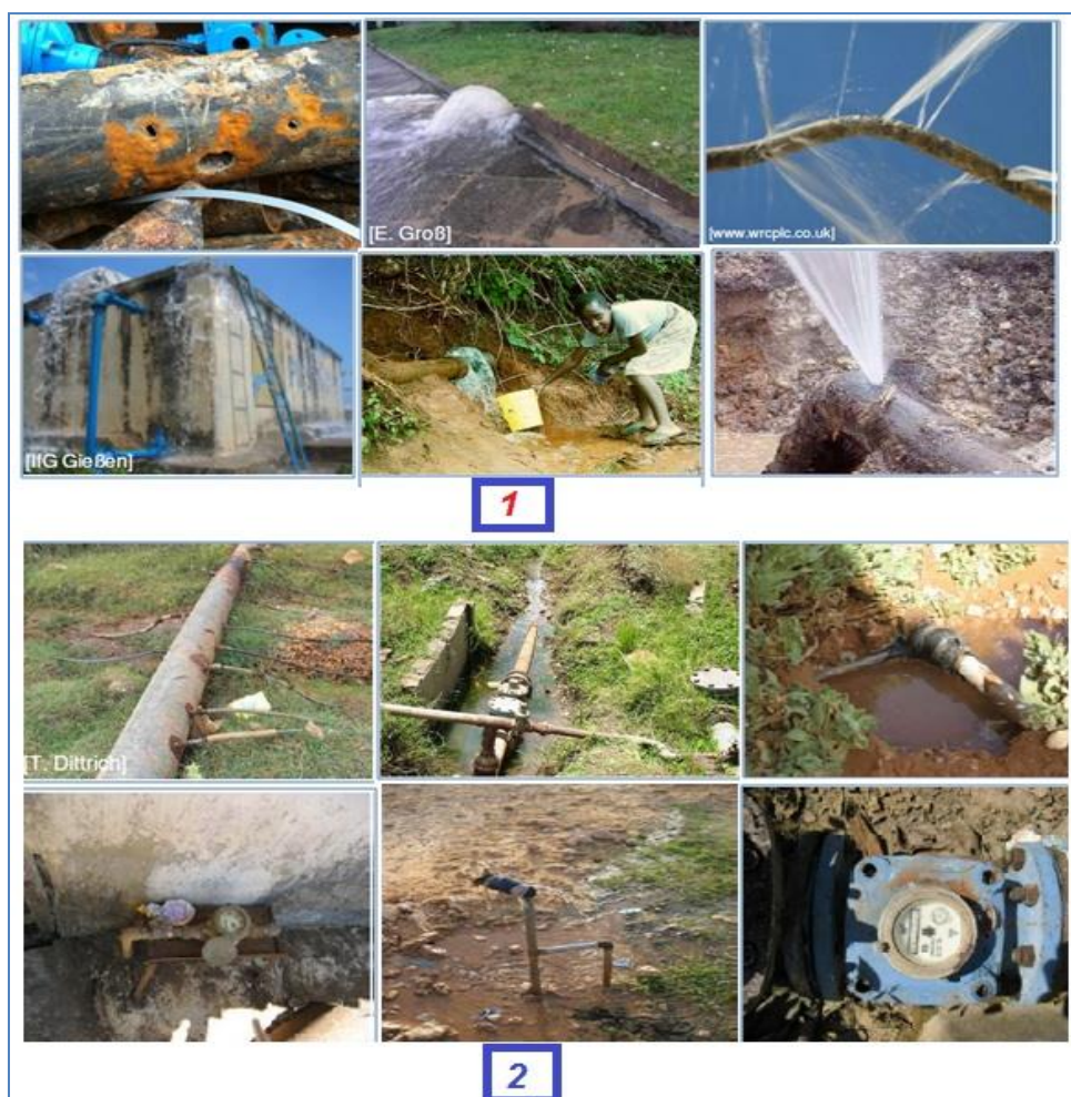
Figure III-2 : les pertes d'eau (1 : pertes physiques ; 2 : Pertes apparentes)
