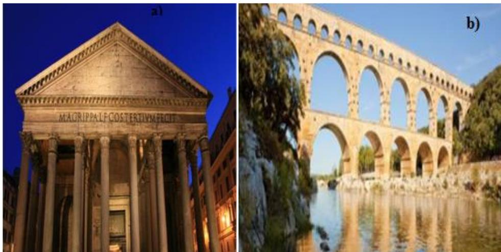
**Figure 1.1:**(a) Le Panthéon à Rome possède la plus grande coupole en béton non armé de toute l'Antiquité, (b) Pont du Gard construit par les Romains avec des joint en mortier contenant ciment pouzzolanique
