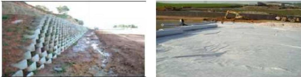
**Figure II.16.** Pose des géotextiles de renforcement.
