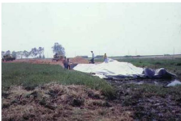
**Figure II.29.** Construction d'une route non revêtue sur une argile organique molle.
