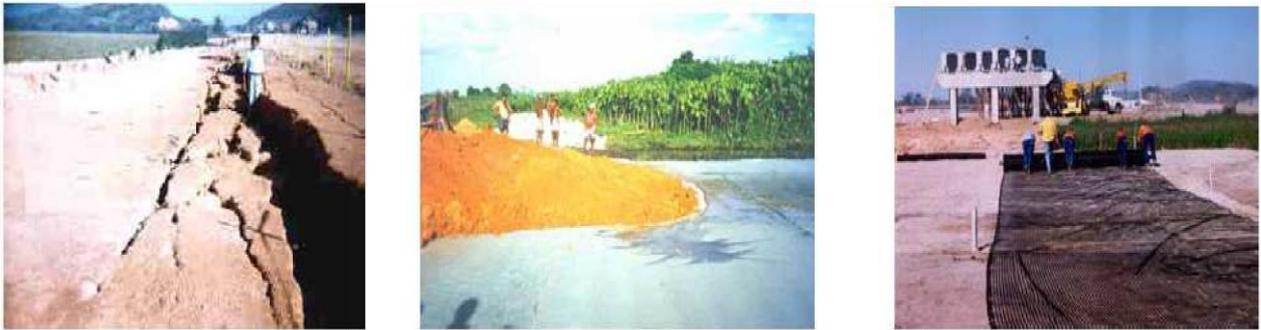
**Figure II.24.** Rupture type d'un remblai non renforcé et utilisation de nappes géosynthétiques en renforcement.
