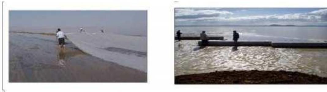
**Figure II.14.** Pose des géogrilles de séparation.
