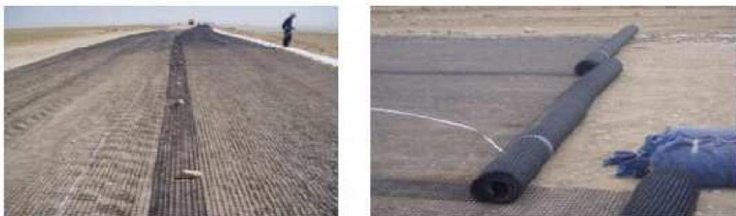
**Figure II.23.b.** L'utilisation du géogrille dans le renforcement.
