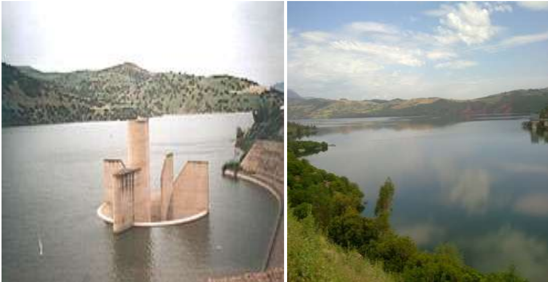
Figure 05 : image de barrage Hammam Debagh (photo personnel)
