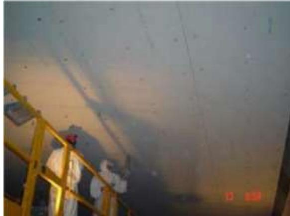
**Figure II.26. Installation d'une protection thermique rapportée sur la dalle d'un tunnel**
