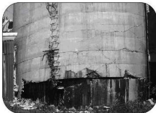
**Figure I.11. La détérioration des silos-tours en béton due à l'attaque des acides d'ensilage.**
