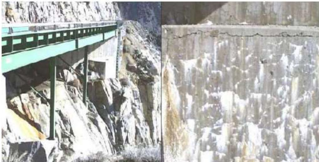
**Figure I.12. Des cas pathologiques d'éléments en béton en contact de sulfate.**
