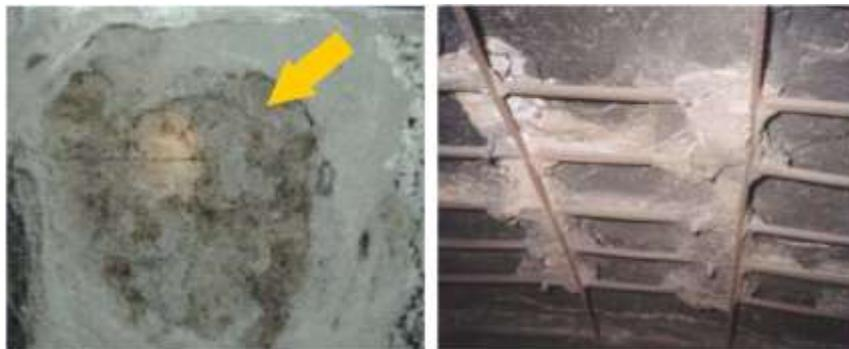
Figure II.9. Ecaillage lors de l'incendie du tunnel mont blanc [Toumi B., 2010].
