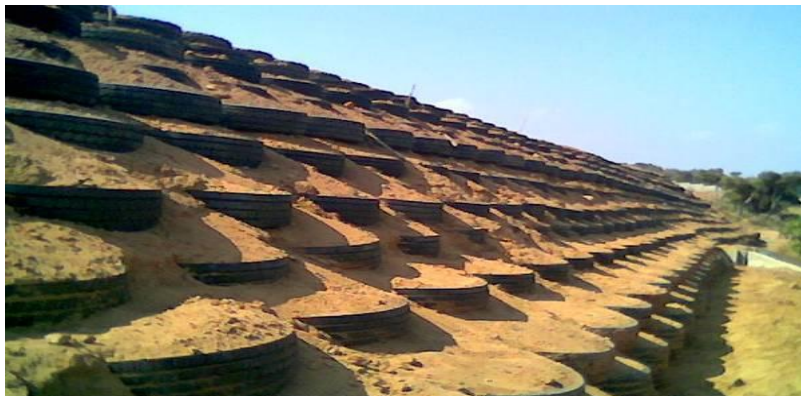
Figure I-1: Protection d'un talus par les pneus réformés
