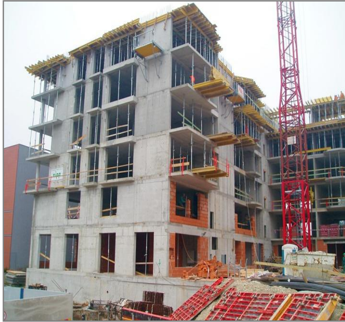
Figure III. 1: Constructions contreventées par voiles en béton armé.
