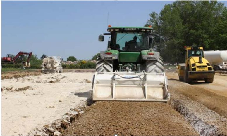
**Figure I.1** Stabilisation des sols avec de la chaux ou du ciment [4].
