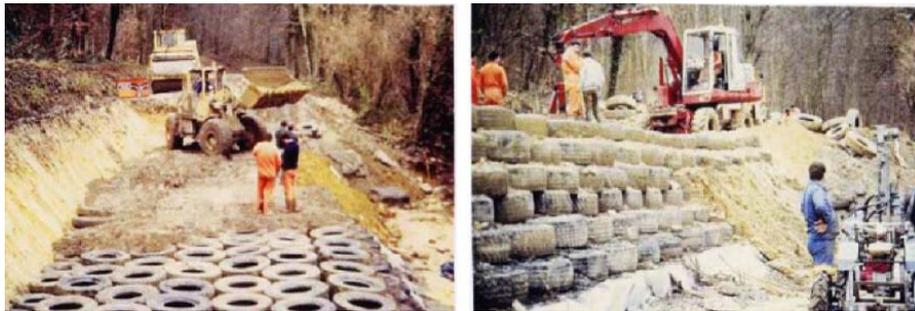
**Figure II.14** La technique de Pneusol.
