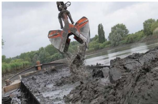
*Figure II.32 Dragage des sédiments [50].*
