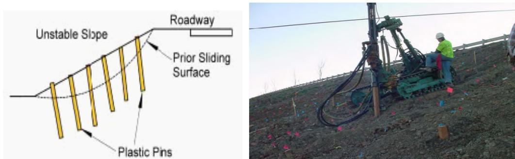
**Figure II.27** Renforcement des talus par des épingles en plastique recyclé [18].
