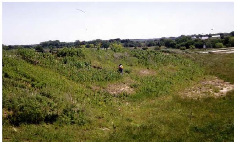
**Figure III.29** Photographie du côté sud du remblai présentant les zones de glissement S1 (gauche), S2 (centre) et S3 (droite). [14]
