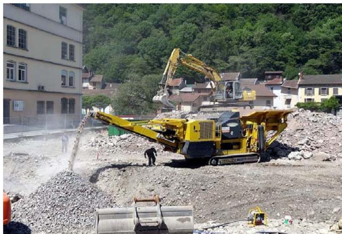
*Figure II.2 Le broyage du béton [35].*
