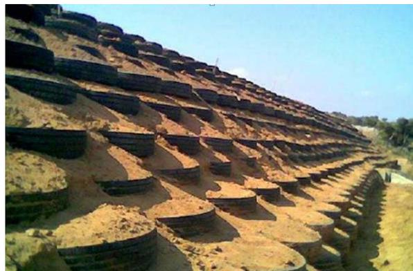
**Figure I.5** Application des pneusol dans la stabilisation des talus. [14]
