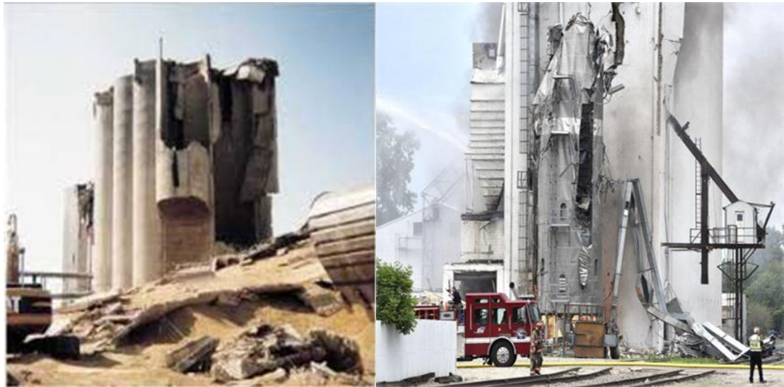
Figure I.13 : Explosion d'un silo en béton armé "céréale". 21
