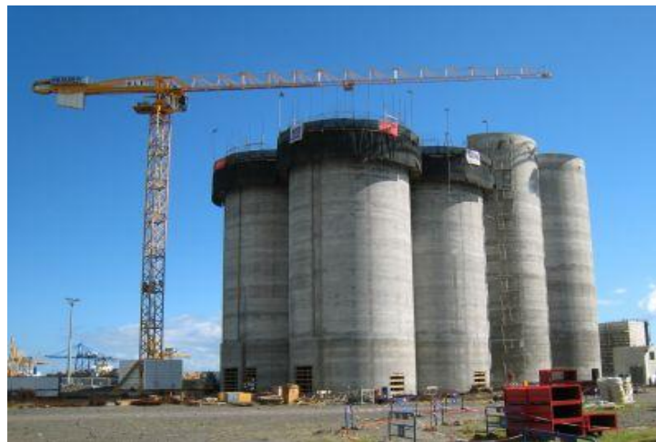
Figure I.12 : Exécution du fût cylindrique par un coffrage glissant 21
