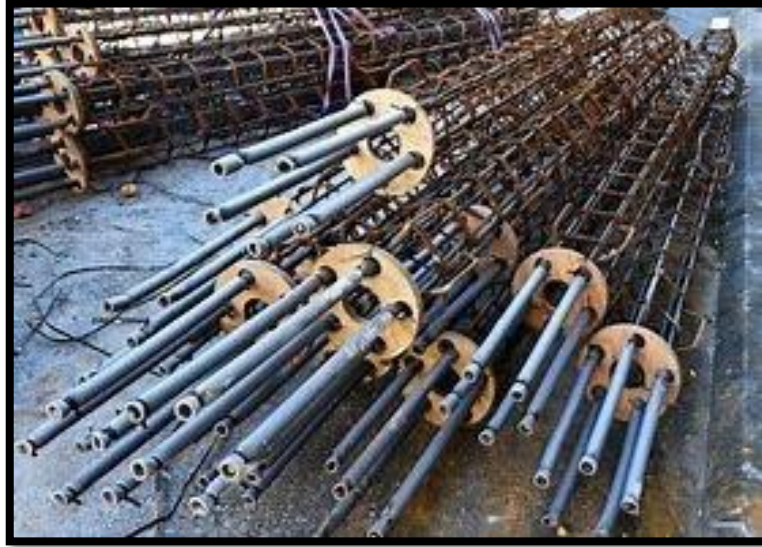
Fig. V.11 - Exemple de ferrailage des pieux.
