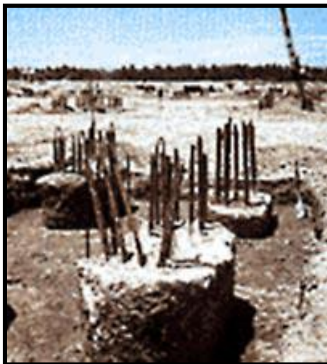
Fig. V.16 - Têtes de pieux dégagées.
