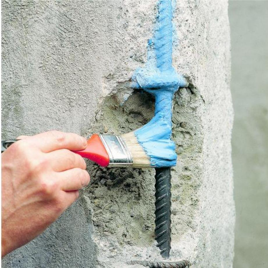
**Figure 4.4** : une application d'une protection d'armatures (mortier anticorrosion) [AFGC 03].
