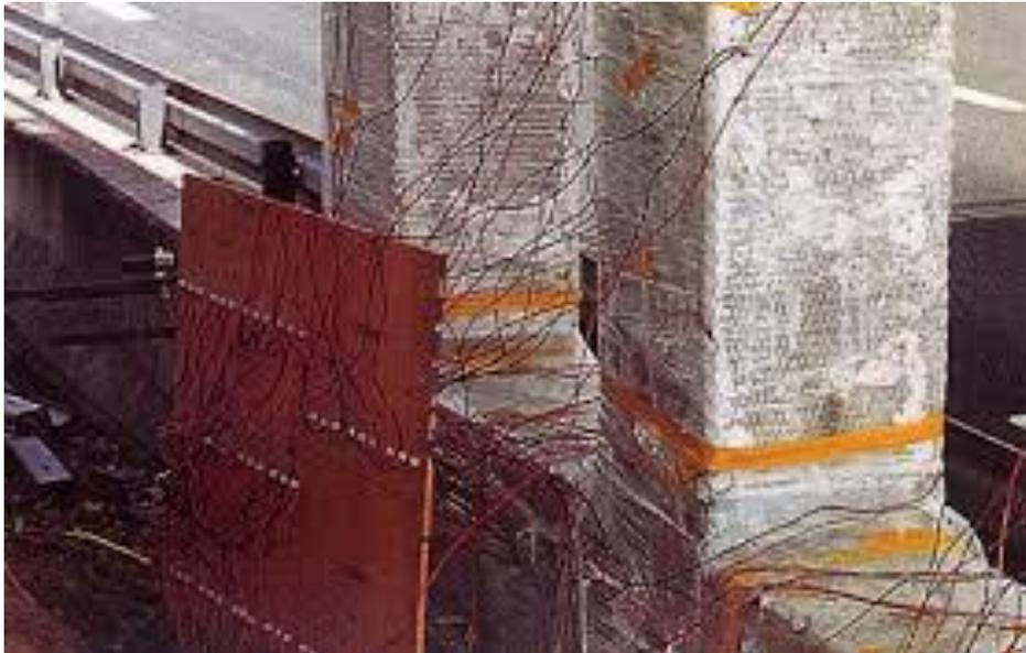
**Figure 4.2** : une extraction électrochimique des ions chlorures (réalcalinisation) [CEFRACOR].
