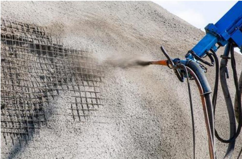
**Figure 4.9 : Projection de béton [AFGC 03].**
