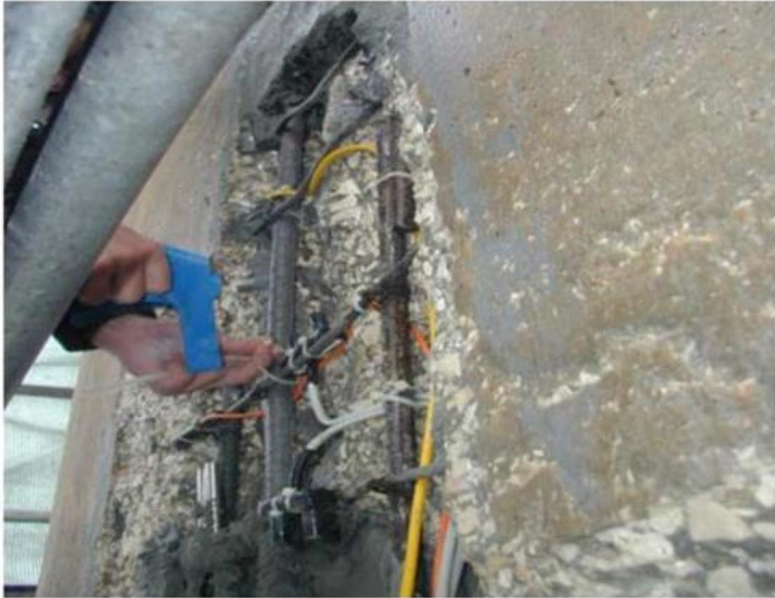
**Figure 3.11** : Instrumentation d'une zone réhabilitée après corrosion [AFGC 03].
