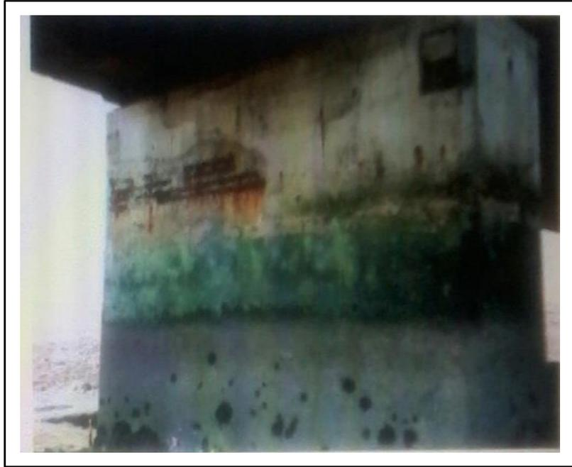
**Figure 2.7** : Pile en zone de marnage [AFGC 03].
