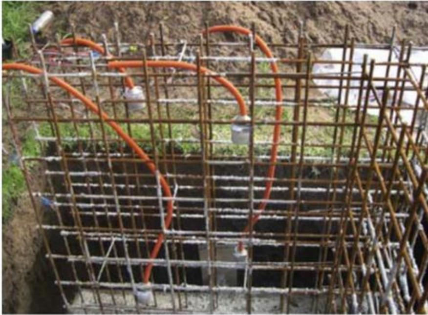
**Figure 3.7 :** Capteur multiple de corrosion intégré dans une nouvelle structure [AFGC 03].
