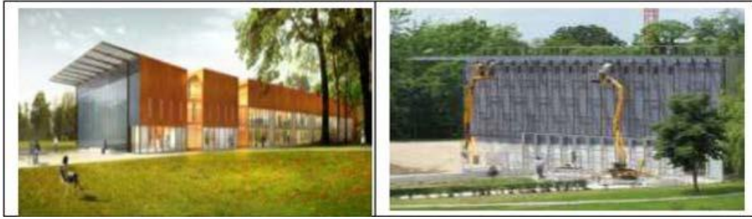
Figure: Mur trombe de la bibliothèque des sciences de l'université de Versailles. Source : Emilie B « Conception de bâtiment solaires »
