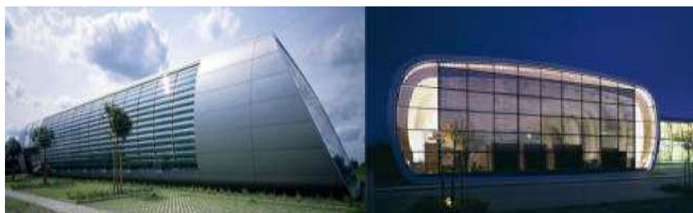
Figure 23 : Siège social Tobias Grau, Allemagne (BRT architecte)
