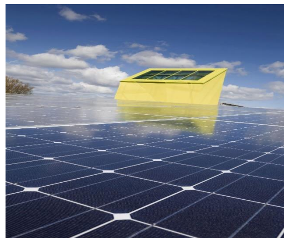
Figure 125 : la toiture d'One Trinity green Source Archdaily.com traité par auteur
