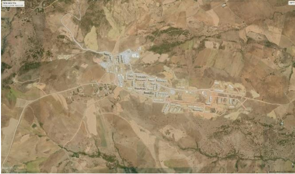
Figure 63: état actuelle implantation des bâtiments au cours de réalisation
