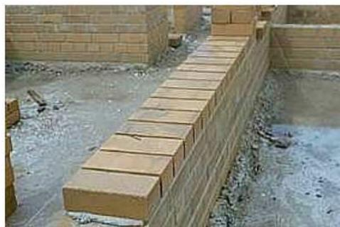
Photo 1 : mur en Blocs de terre comprimée
