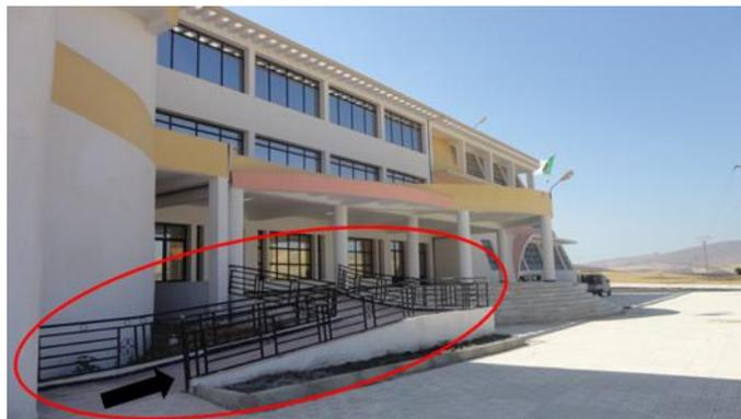
Figure 76 : la rampe d'entrée pour les personnes aux besoins spécifiques
