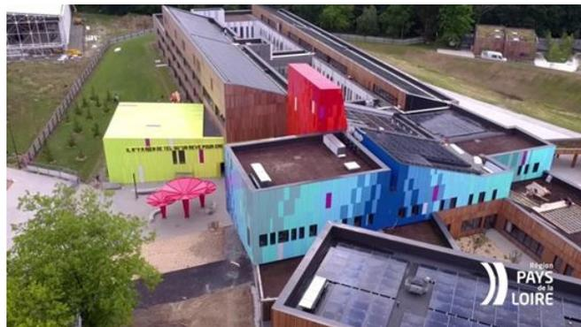
Figure 33: toitures légères inclinées au sud pour le photovoltaïque
