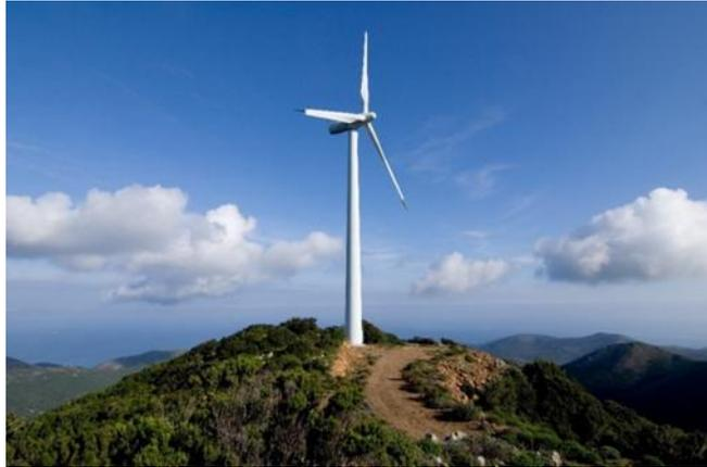
Figure 3: éolienne à axe horizontale
