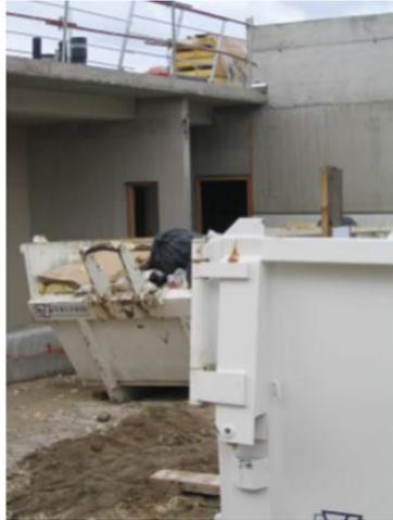
Figure 9: Un exemple de chantier propre sur un projet HQE. Bennes de tri des déchets. Crèche des Chenevres. En cours de construction en 2005.
