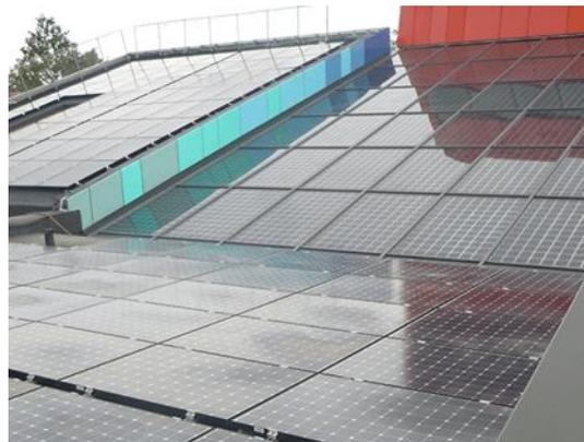
Figure 35: les panneaux hybrides des toitures des blocs d'enseignement
