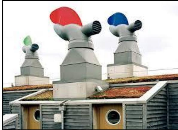
**Figure 24 :** Système de ventilation naturelle par conduite d'air
