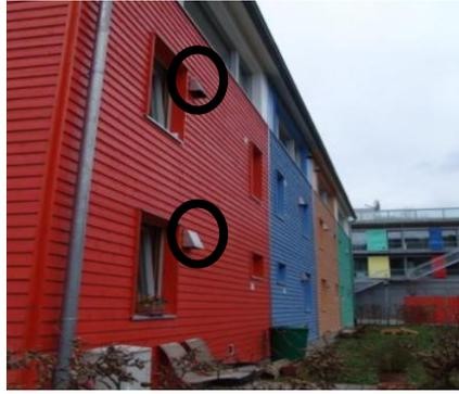
**Figure 52 :** Débouchés d'aération sur la façade nord
